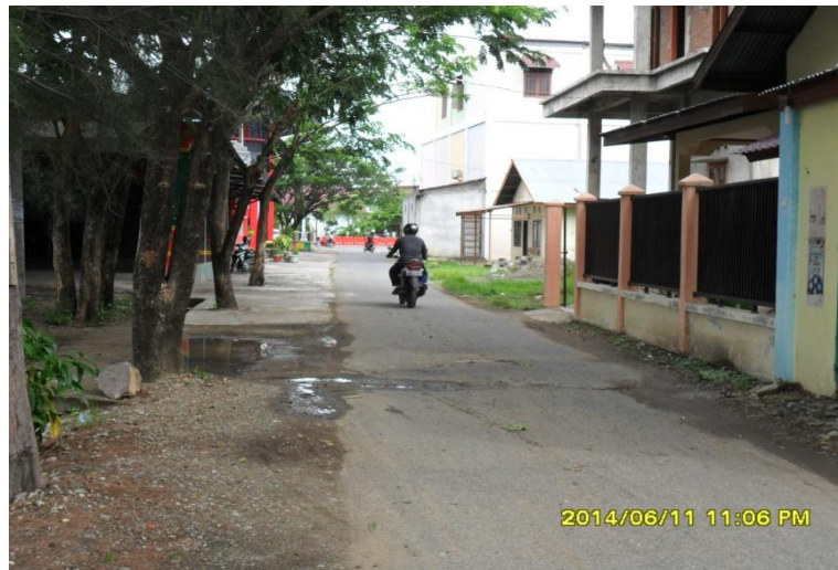
Gambar 4. Kondisi Fasilitas Umum Jalan Raya
